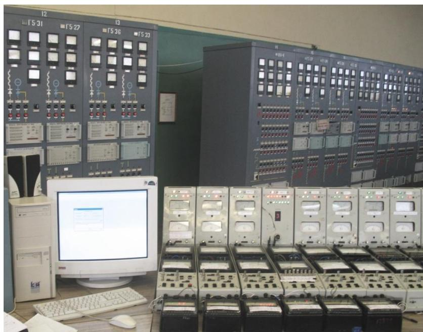
б) зал управления – устройства контроля за проведением эксперимента
