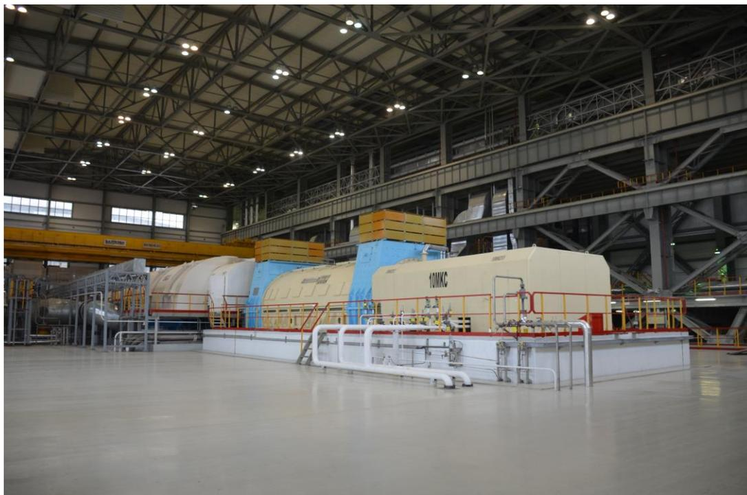
Рисунок 1.4 – Турбогенератор ТЗВ-1200-2АУЗ в машинном зале электростанции [74]
