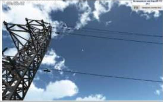
20. Разрегулировка проводов
